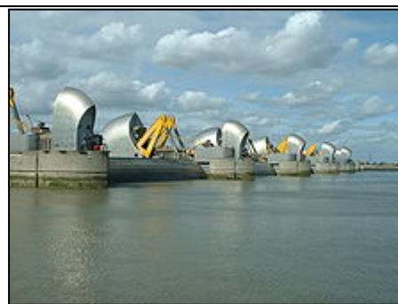
Bariéry na Temži, největší stavitelné zábrany proti záplavám na světě
